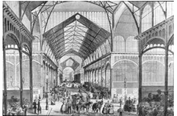
Détail des Halles avec ses structures
